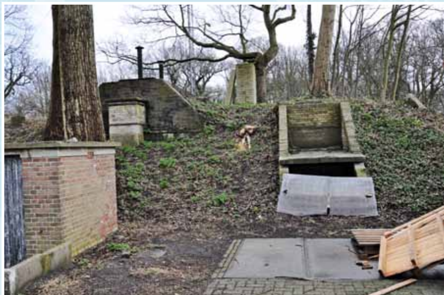
Bunker anno 2010 (foto Ben Borsboom)
